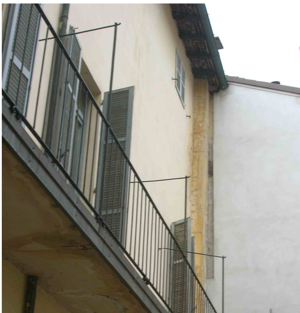
Balcone su cortile interno
